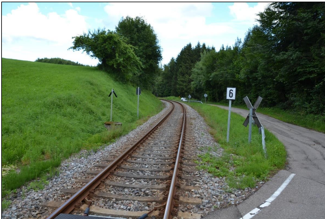
Abbildung 6-1: Sichteinschränkung durch Gelände BÜ 14,8 [ISB21b]
