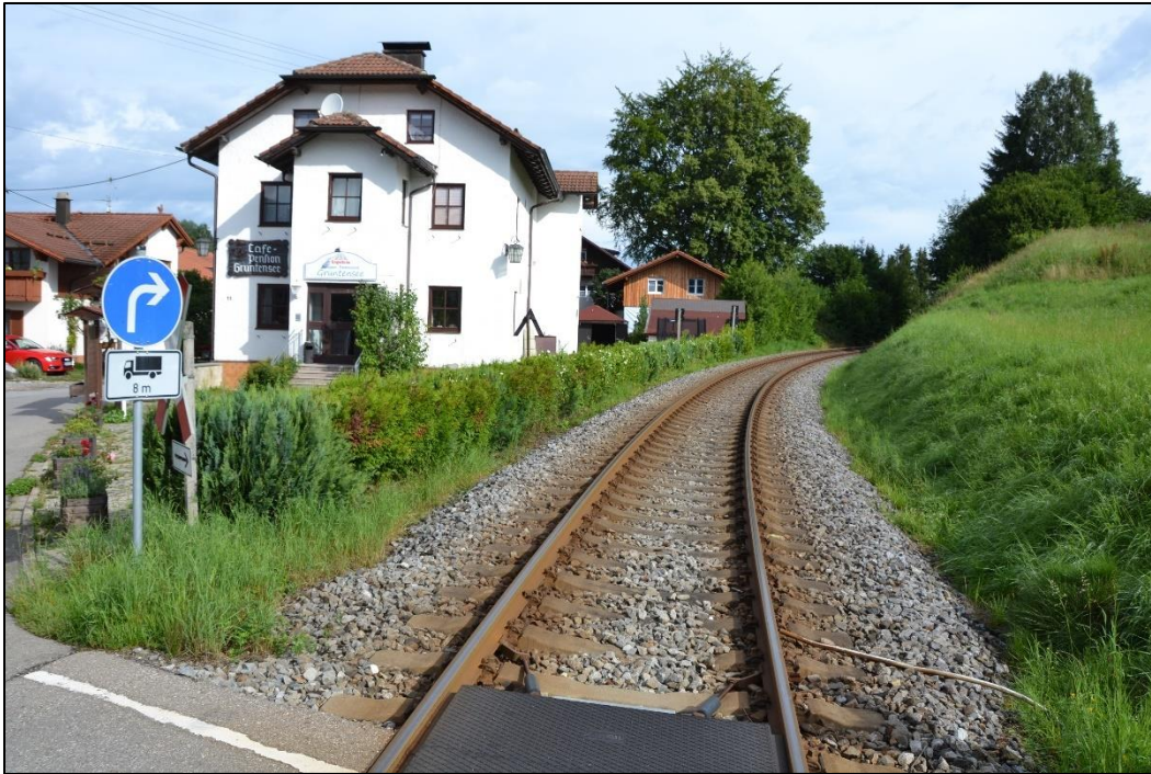
Abbildung 6-2: Sichteinschränkung durch Bebauung BÜ 19,8 [ISB21b]
