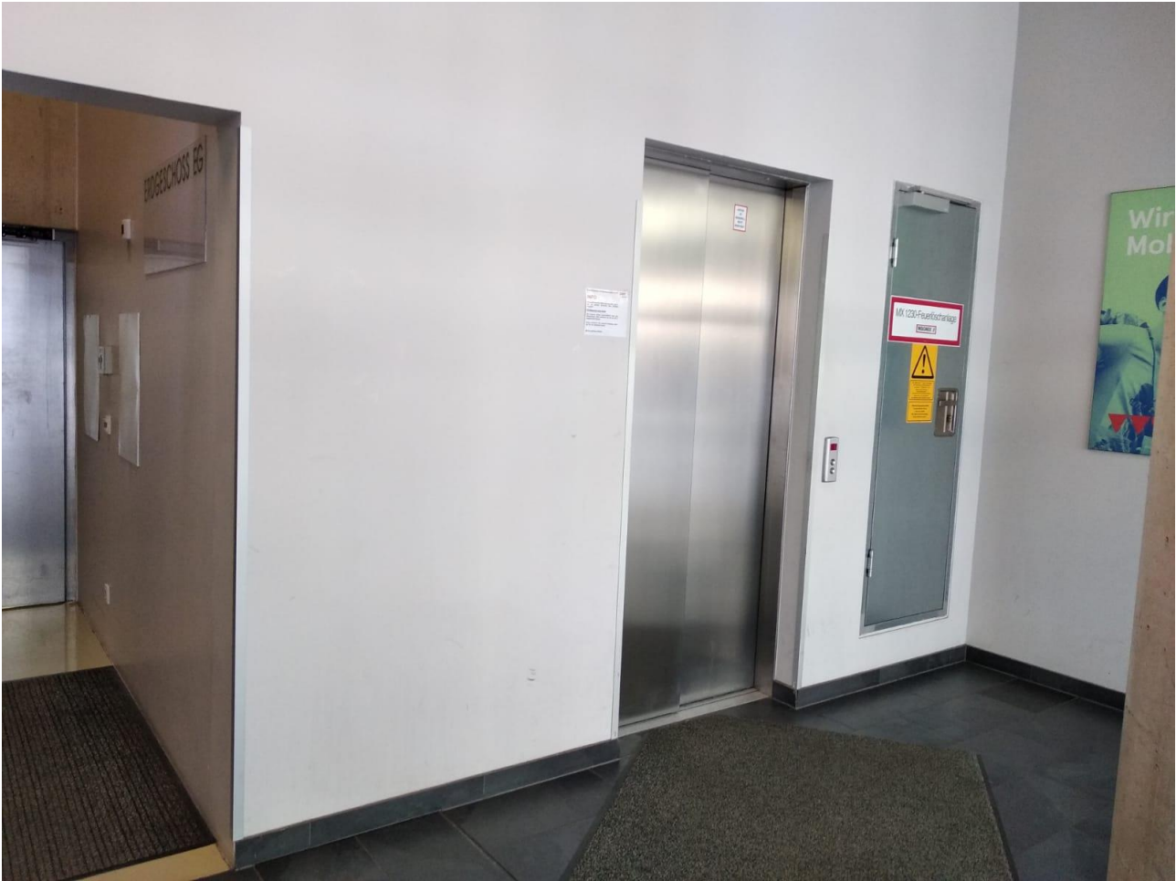
Foto 3: Aufzug Eingang Nord, Sterzinger Straße 3
